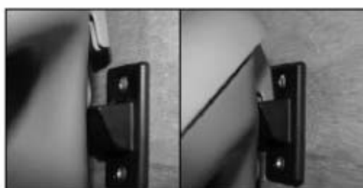
Монтаж установки SafetyWrap® на стену с помощью кронштейнов
